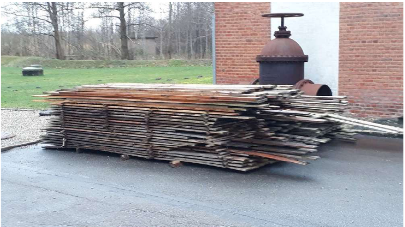
Foto. Brædder til etablering af gangbro.
